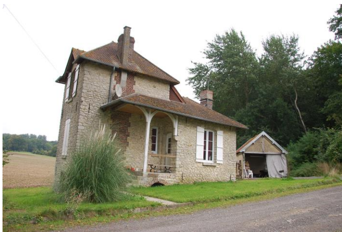
Ancienne maison de gardien rue de Séchelles (immeuble n°2)
